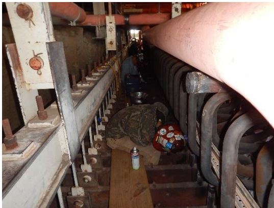
Tertiary SH butt welds and PT UT NDE
