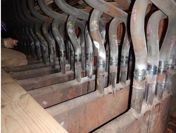
Tertiary SH butt welds and PT UT NDE
